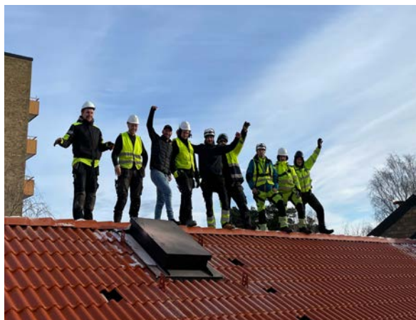
Taklagsfest efter att ha bytt 72.658 st betongpannor. Foto Simon Ragnell
