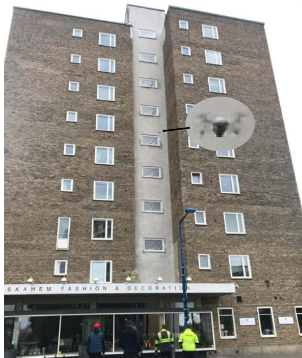
Besiktningen av fasaden på höghuset fick utföras med hjälp av drönare.
